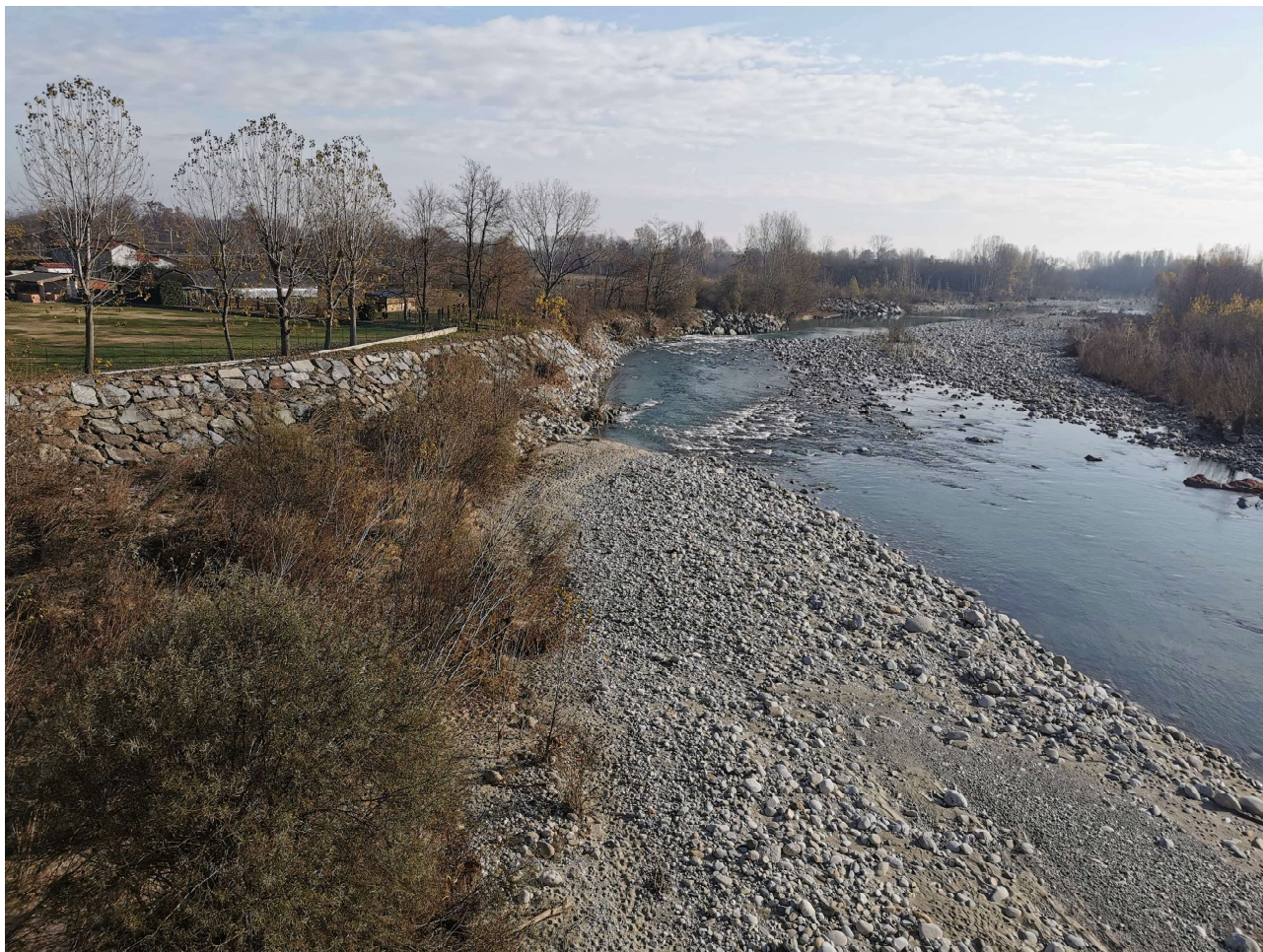
Figura 8.1: Scogliera in opera lungo la sponda sinistra a valle del ponte di Rivarolo C.se. L'intervento previsto consiste nella realizzazione del suo proseguimento fino a raggiungere i pennelli già in opera
