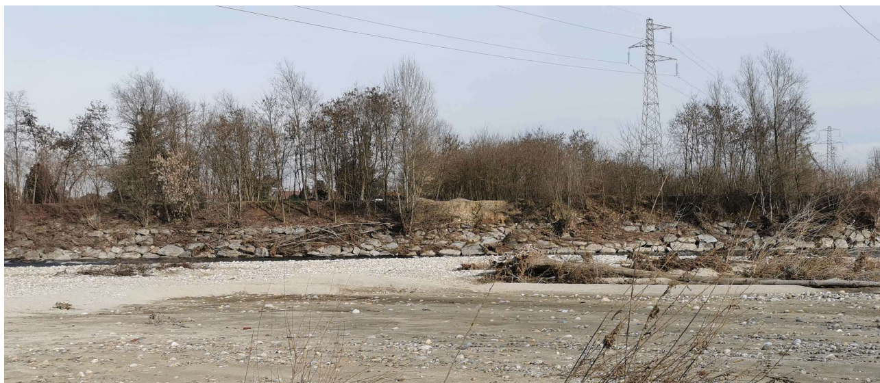
Figura 6.6: panoramica sulla scogliera in massi di cava a difesa della sponda sinistra in corrispondenza del meandro di valle
